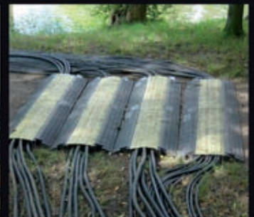
Sichere Überquerung: Kabelbrücken
