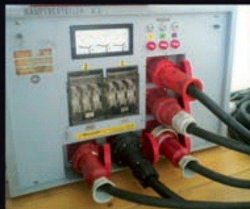
400A Powerlock Hauptverteiler
